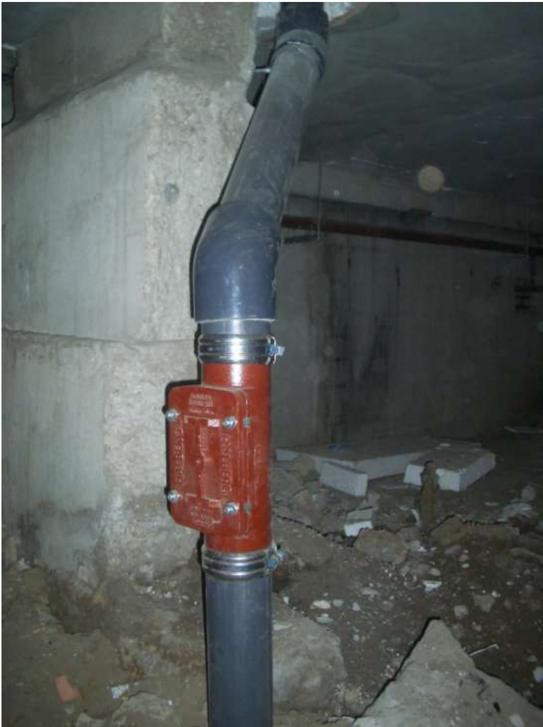
Kanalizācijas sistēmas montāža
