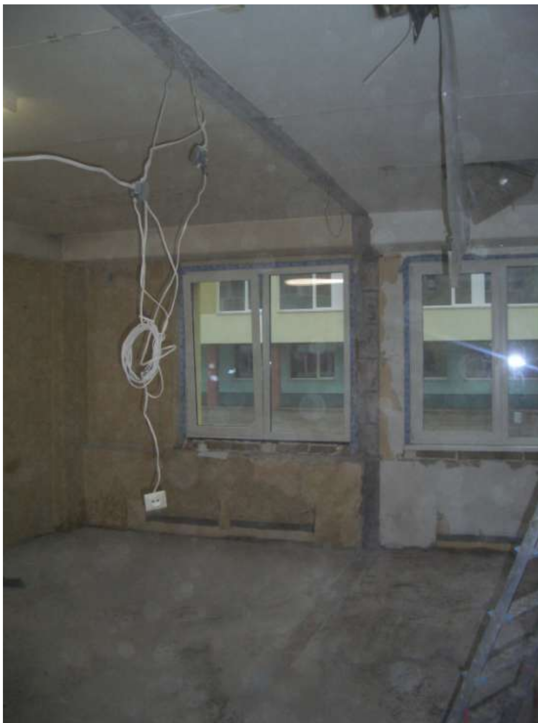
Sienu, grīdu pamatņu, apkures sistēmas demontāža
